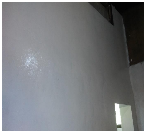
Figura 8. Área de lavado y enjuague al momento de la inspección final.
