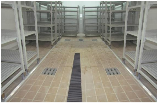
Imagen 6 pisos con desagüe, para facilitar limpieza del área de proceso
