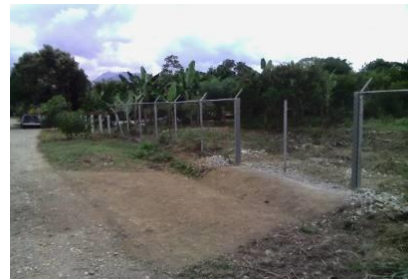
Imagen 5 cercas protectoras alrededor de la planta.
