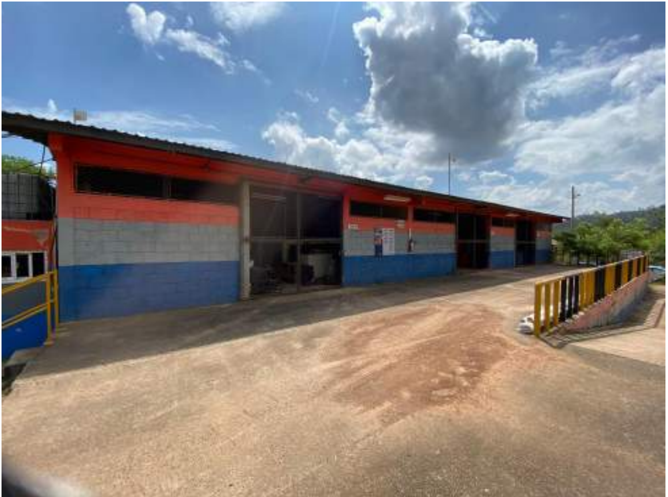
Figura 1. Bodegas de centro de acopio Fuente: propia
