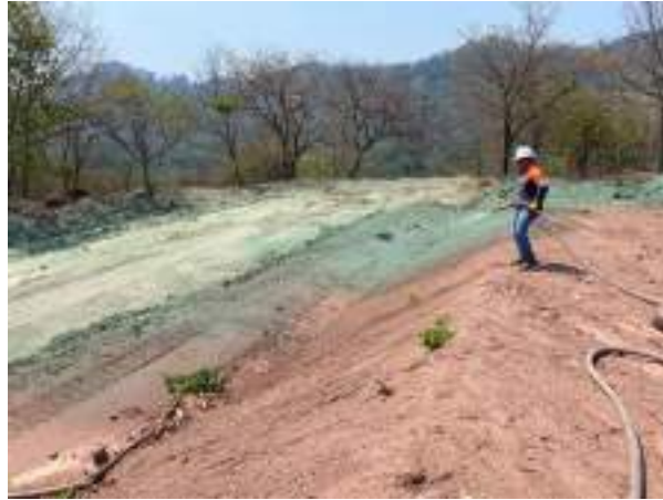
Figura. 4 Aplicación de hidrosiembra
