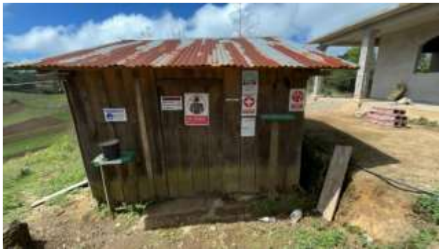
Figura 27 Bodega de insumos organizada, cumpliendo criterios al exterior.
