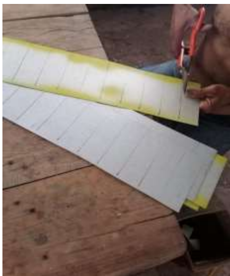
Anexos 19. Cortar las placas a 5cm a lo alto y 15 a lo ancho.
