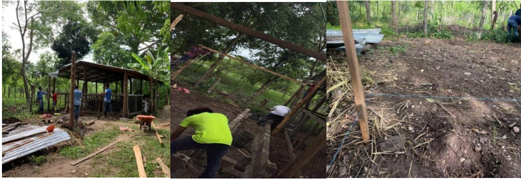
Figura 19. Construcción de la estructura.
