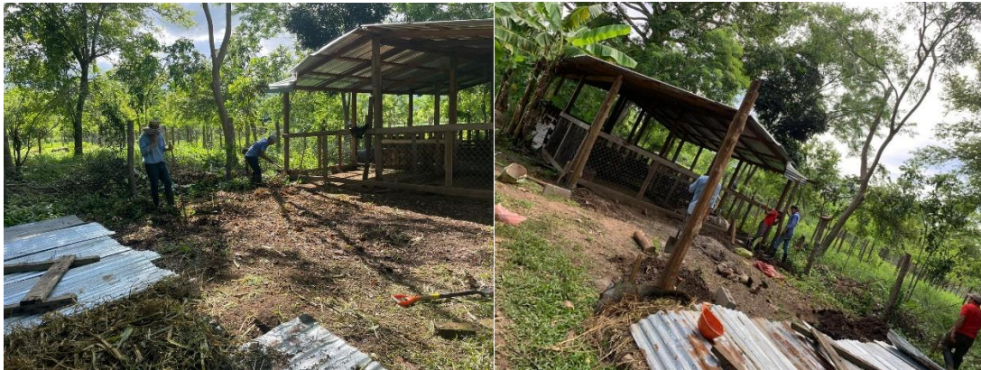
Figura 18. Limpieza del área para la construcción de la lombricultura.
