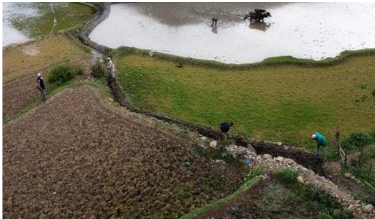
Figura 10. Construcción de zanjas de infiltración para el aprovechamiento de aguas lluvias.
