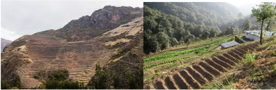
Figura 12. Terracerías de piedra y tierra
