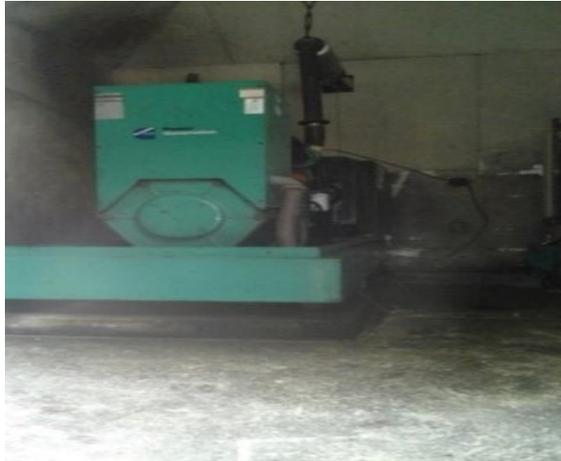
**Figura 13.** Tanque y generador instalados sobre cemento para soportar el peso del generador y la cantidad de combustible almacenado.
