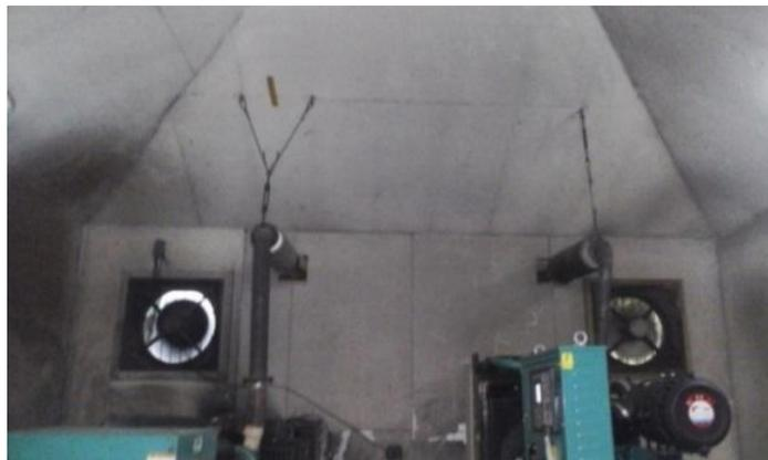
**Figura 12.** Paredes forradas con material aislante acústico para reducir la contaminación sonora en el centro
