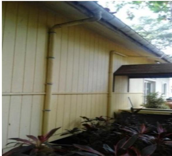
**Figura 3.** Manejo adecuado de conductos de aguas pluviales para evitar acumulación de hojarasca y criadero de larvas.
