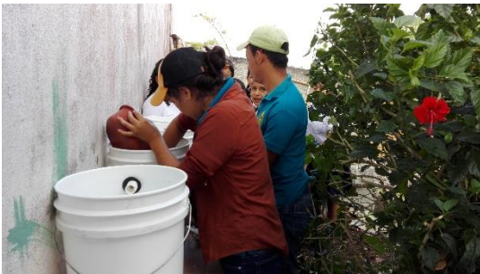
Paso 6. Colocación del material filtrante.
