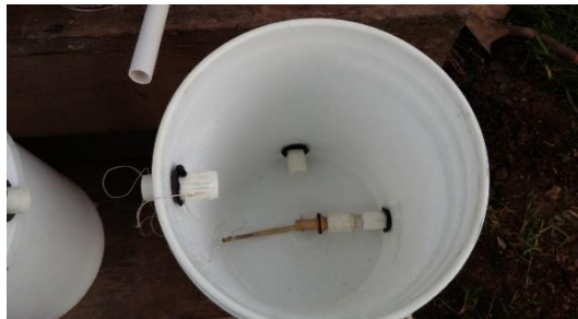
Paso 7. Regulación de la bomba de flote
