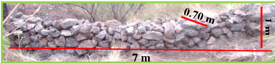
Figura 19. Controles de torrentes en la parte alta del terreno
