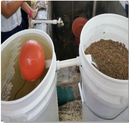
Paso 6. Colocación de materiales filtrantes en los baldes
