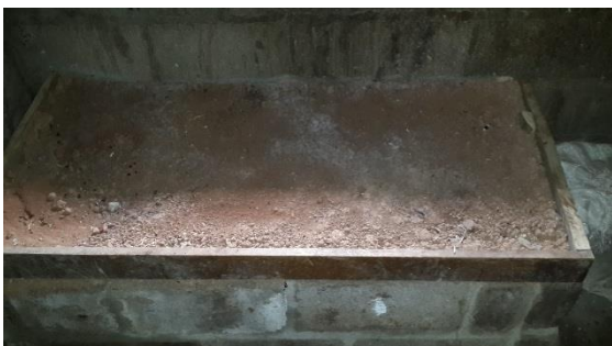
Figura 7. Preparación de la mesa para la construcción de estufas mejoradas
