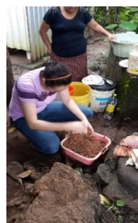
Figura 8. Preparación del barro para la construcción de las estufas mejoradas
