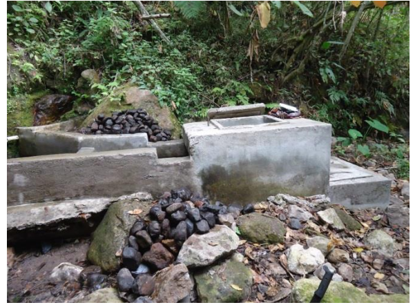
Obra toma abastecedora de agua de la comunidad de Quilaperque
