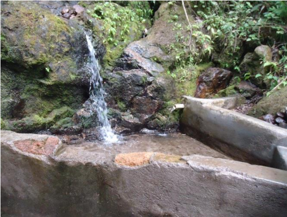
Obra toma abastecedora de agua de la comunidad de Quilaperque
