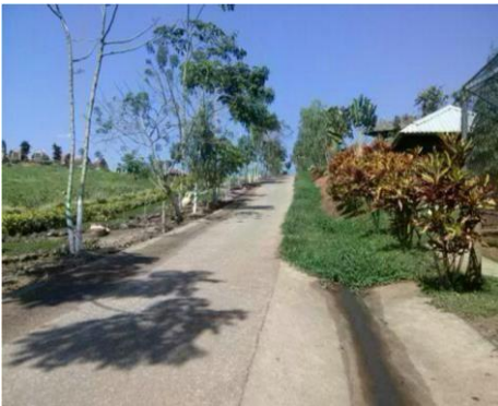
Figura 3 Aguas Residuales desembocadas en la calle
