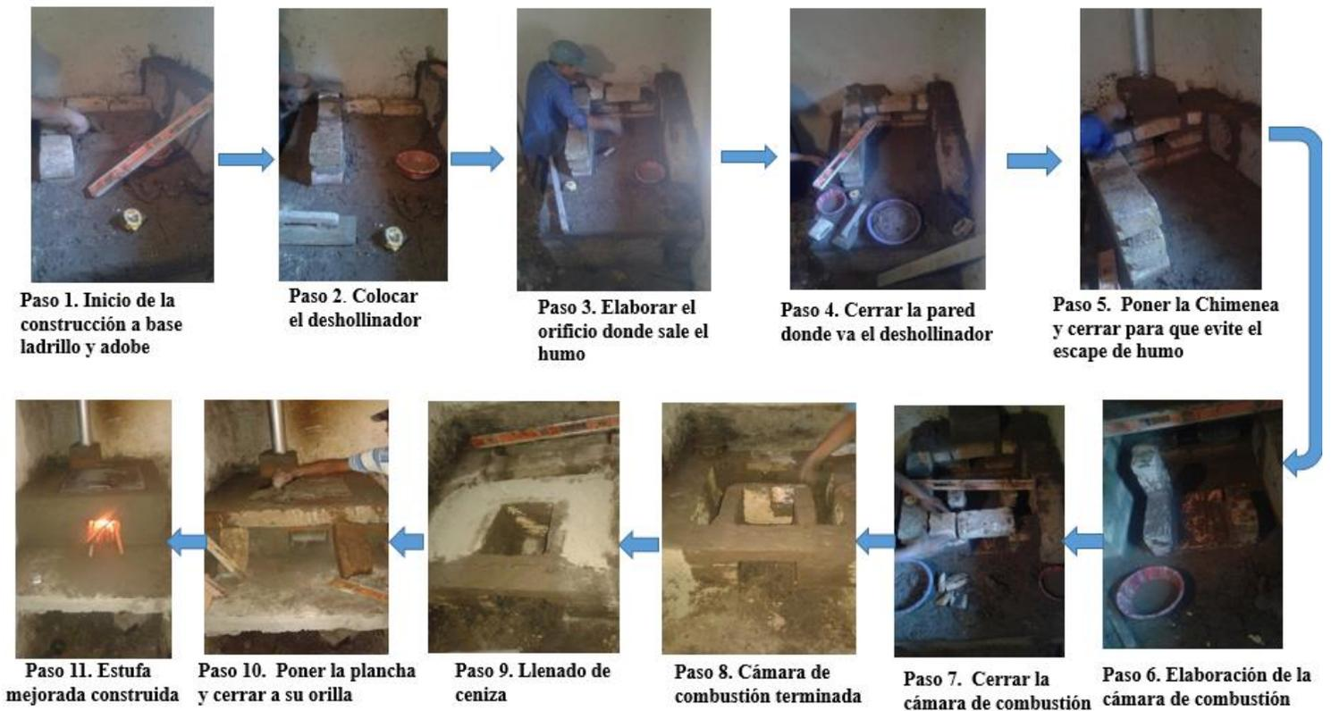
**Figura 16.** Esquema fotográfico del proceso de construcción de la estufas mejoradas
