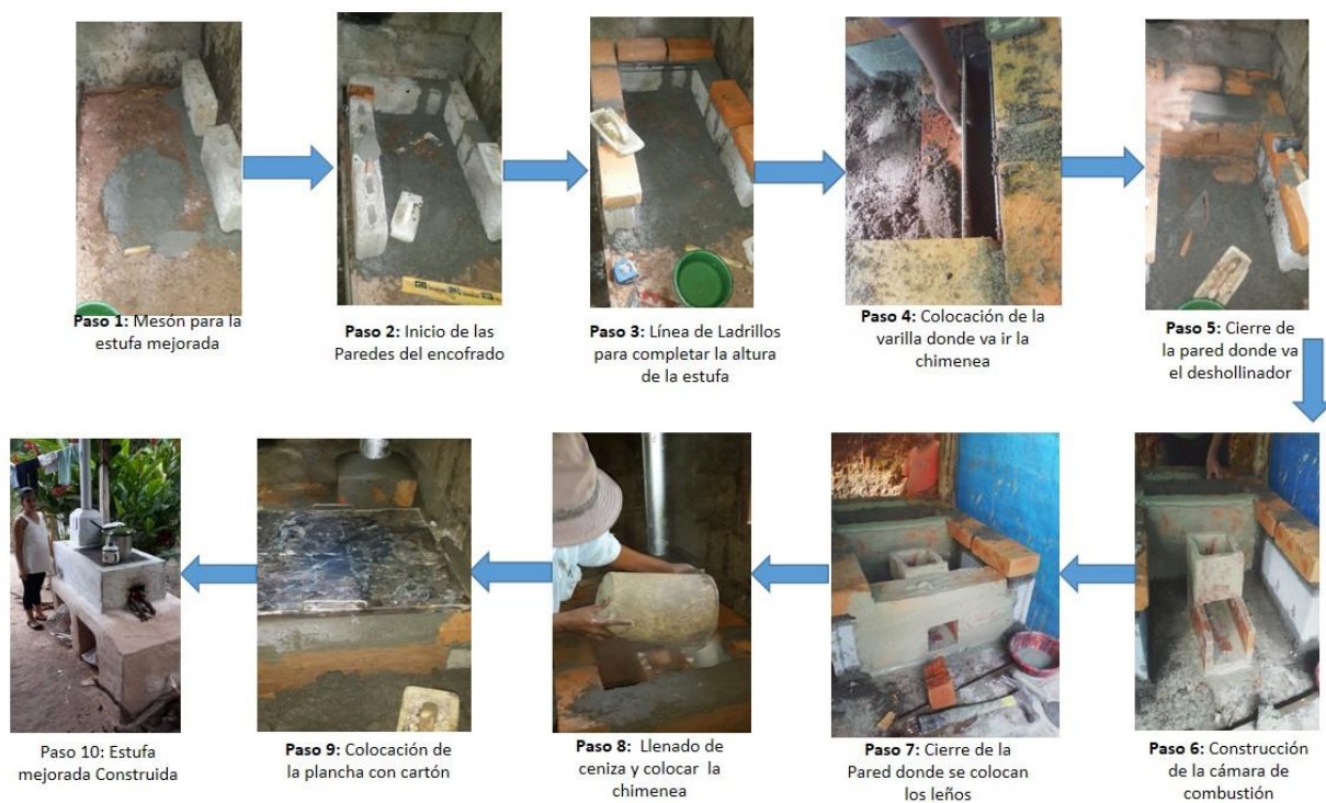
Figura 12. Proceso de construcción de estufas mejoradas en los municipios de Gualala e Ilama
