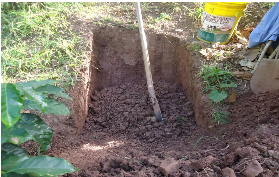
Anexo 5. Construcción de calicata
