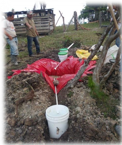
Figura 25. Construcción de Biojardinera
