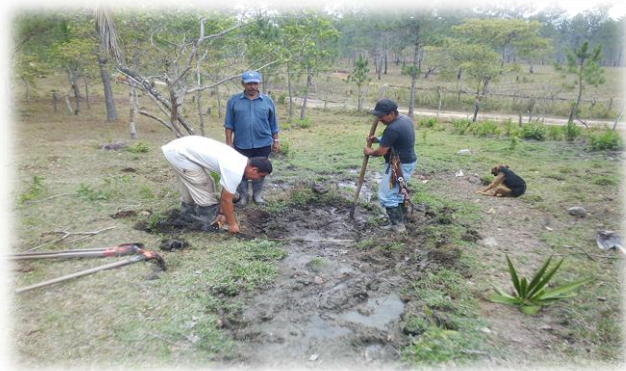
Figura 3. Identificación del sitio a construir, Fuente Maricruz Ortega
