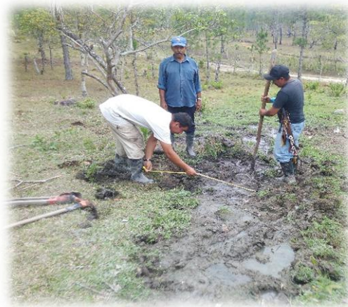
Figura 5. Profundidad de excavación para la biojardinera, fuente Maricruz Ortega
