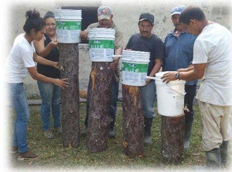
Figura 23. Colocación del filtro en el lugar de establecimiento
