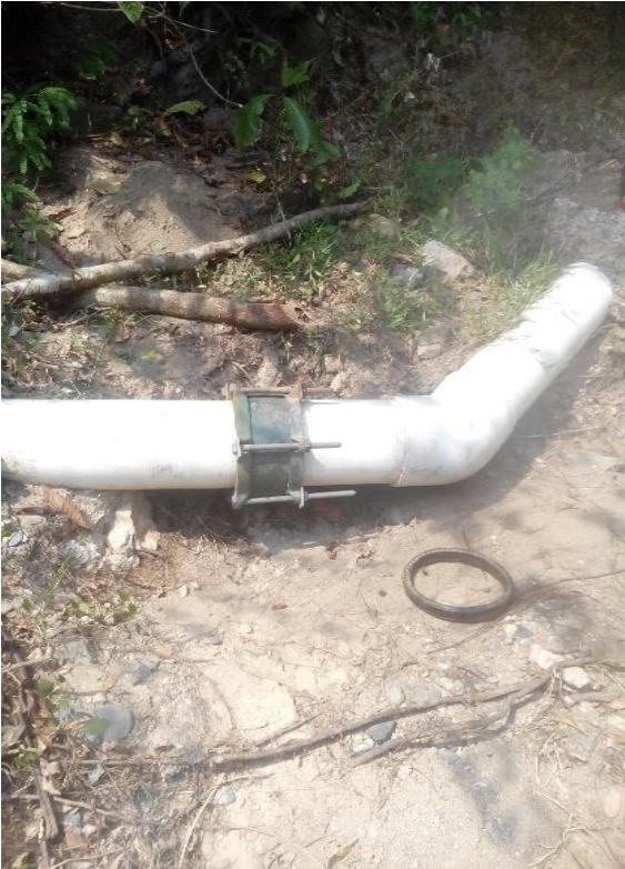
Anexo 8. Tubo vulnerable a daño y válvula de aire
