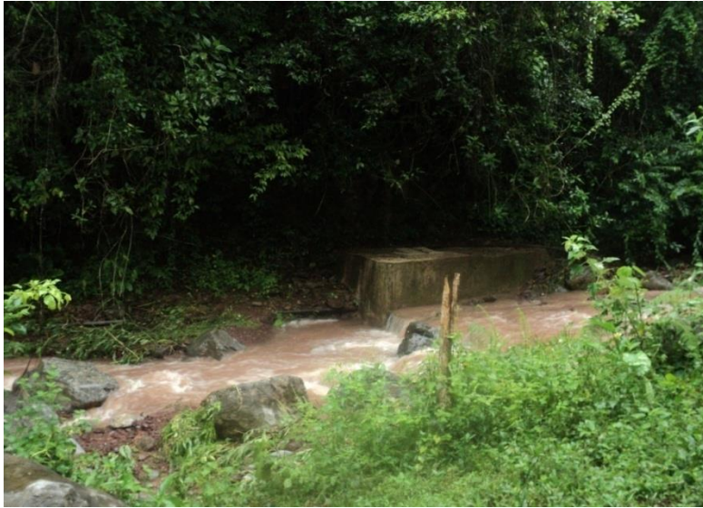
Figura 1. Obra de toma, fuente de agua Quebrada Calichosa de la comunidad del Guanacaste
