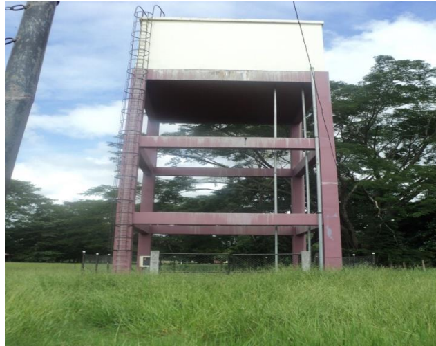
.Pozo y tanque de pastos y forrajes
