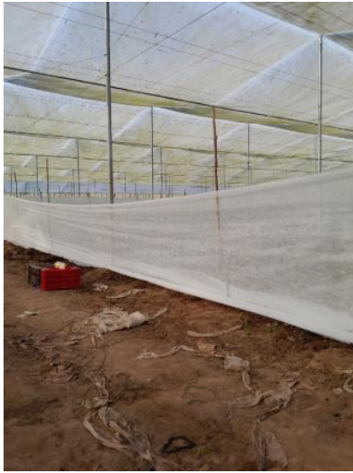
Anexo 6 Colocación de manta térmica como división
