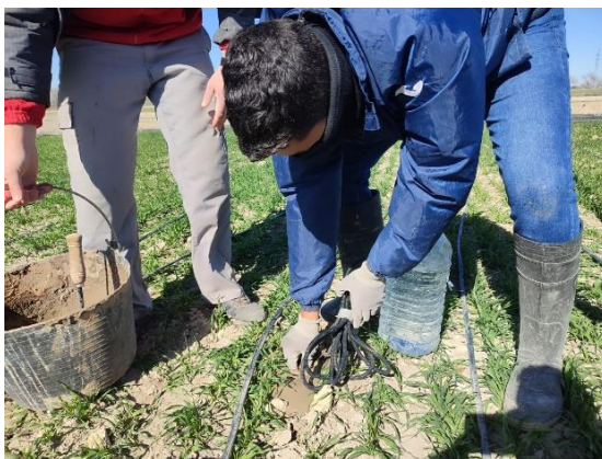
Anexo 9. Instalación de sensor de humedad
