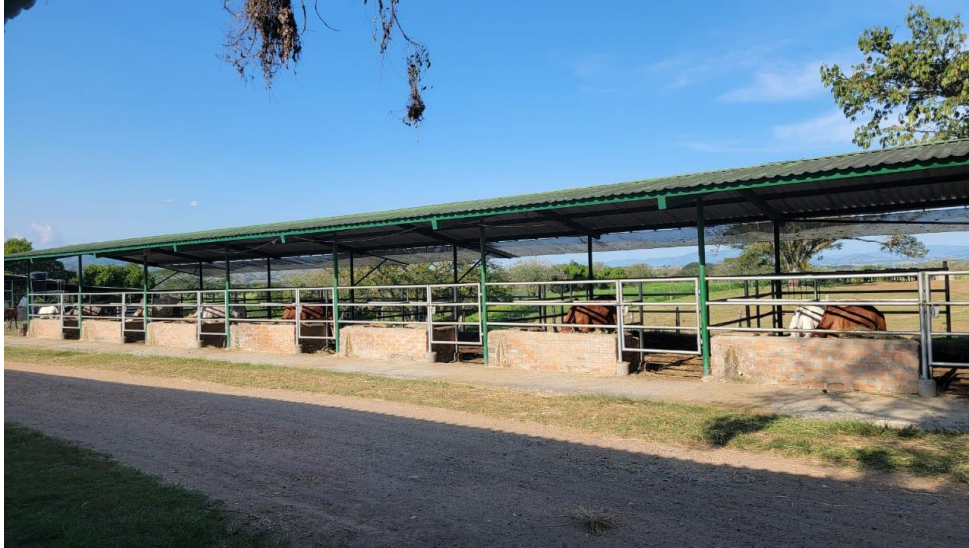
Anexo 5 Cerca perimetral
