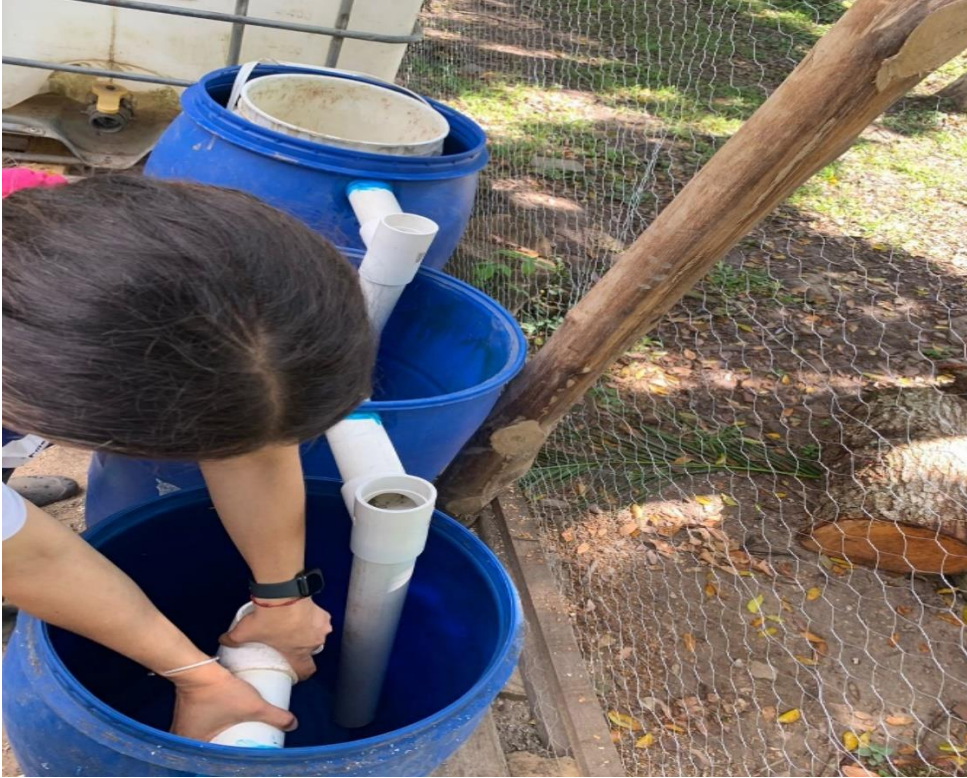
Instalación de los filtros
