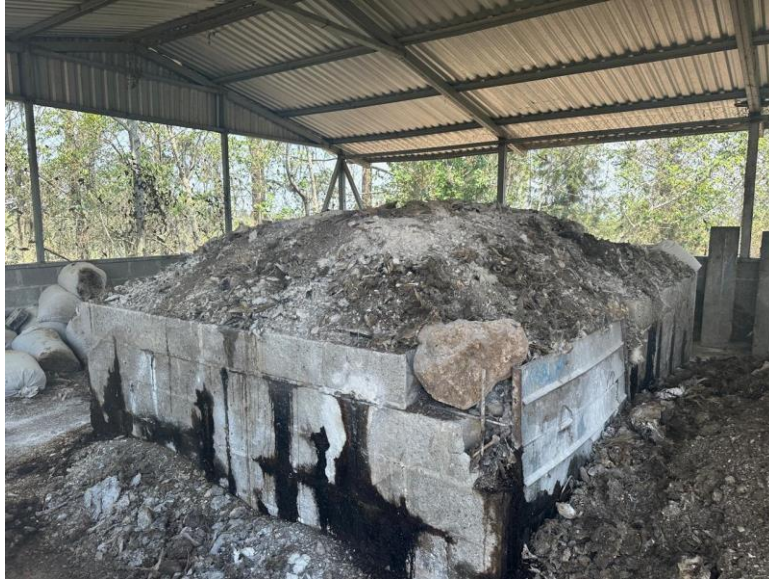
Anexo 3: Compostera de descomposición de aves muertas al final del lote.
