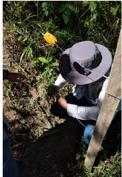
Anexo 13. Instalación de aislador para
