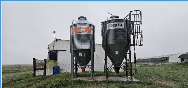
Ilustración 6. Silos alimentación cachorrera reposición uno y dos
