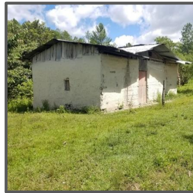
Figura B Vivienda de techo de zinc
