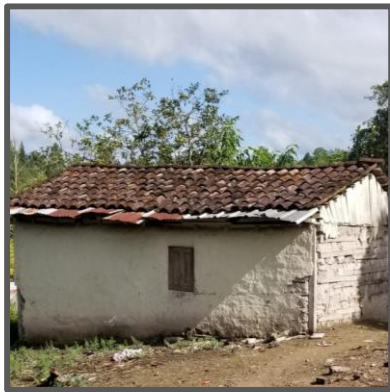
Figura A. Vivienda de techo de teja
