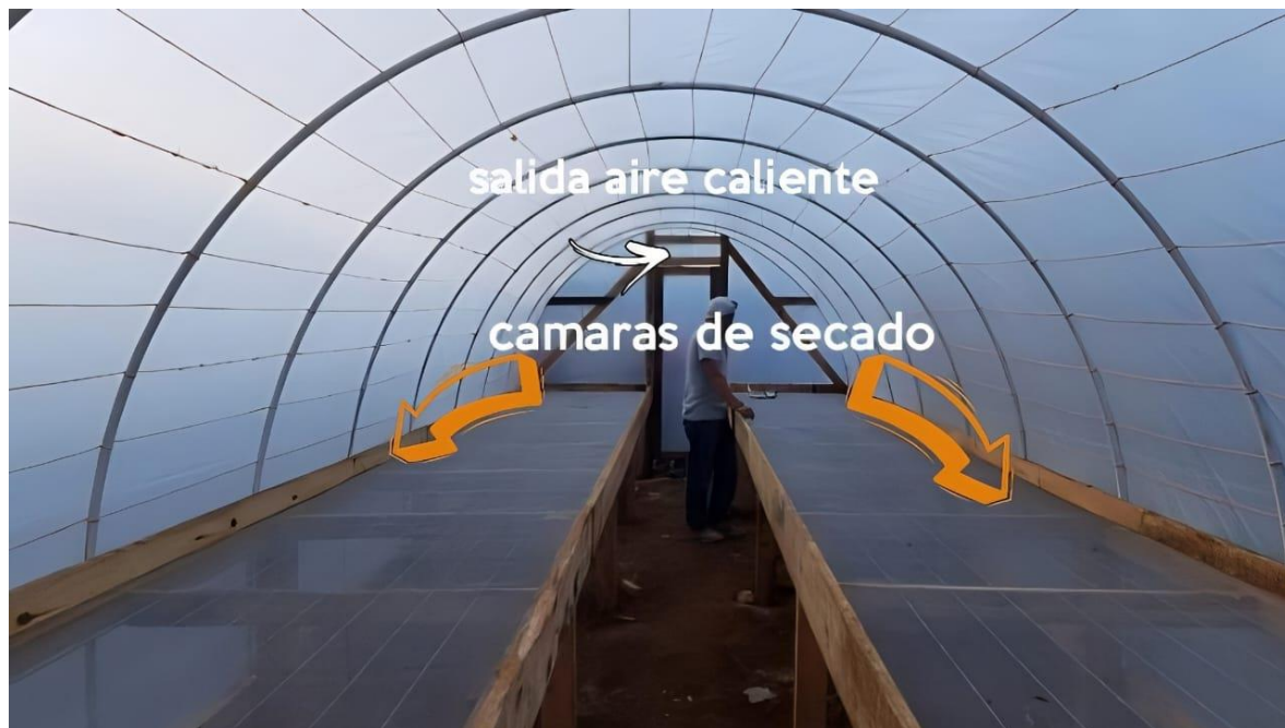
Figura 1 Partes internas del secador solar de granos tipo
