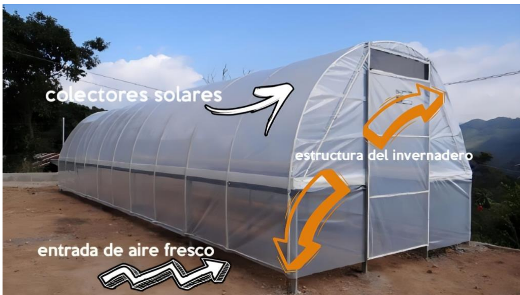
Figura 2 Partes Externas del secador solar de granos tipo domo.
