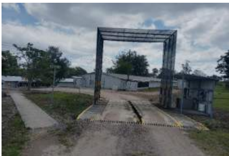
Anexo 1. Arco sanitario para la desinfección de vehículos
