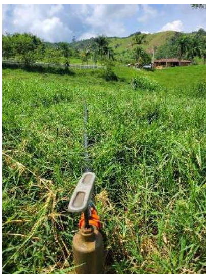
Anexo 13: Llave de paso de agua
