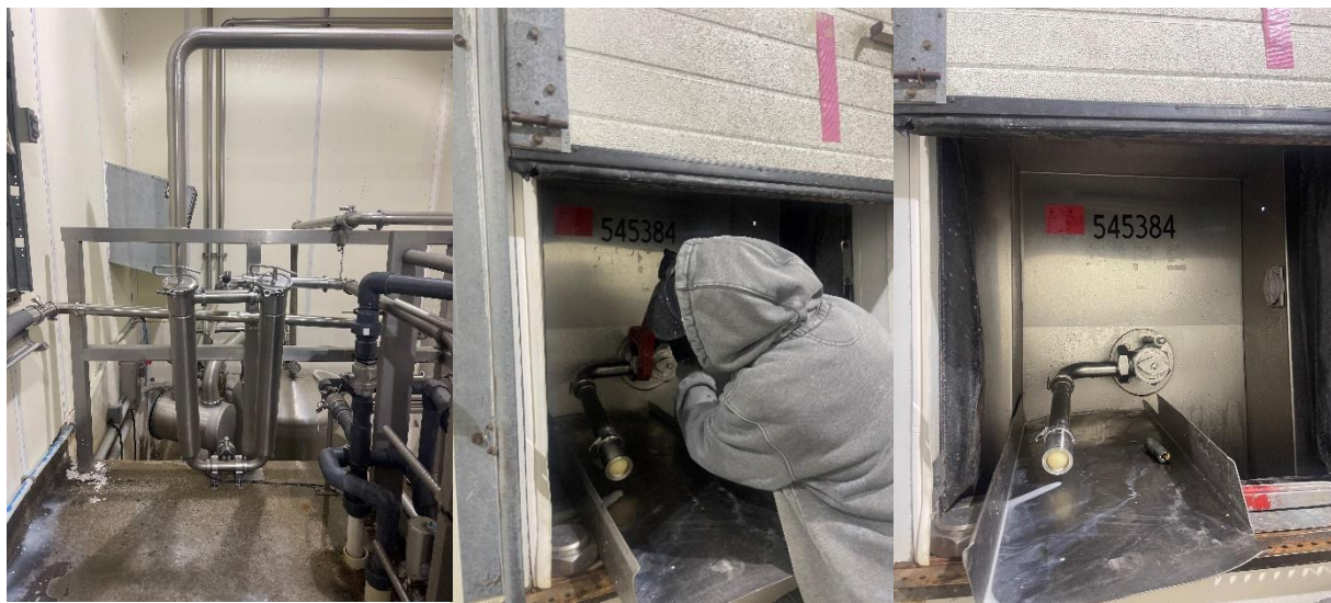
Anexo 2. Cambio de tanque
