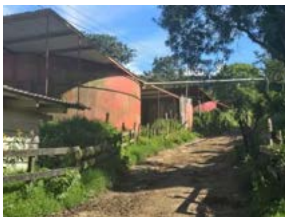
Figura 33. Tanques de almacenamiento de agua provenientes de la captación pluvial.
