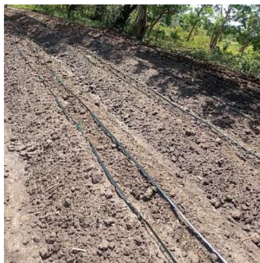
Anexo 2. Instalación de sistema de riego
