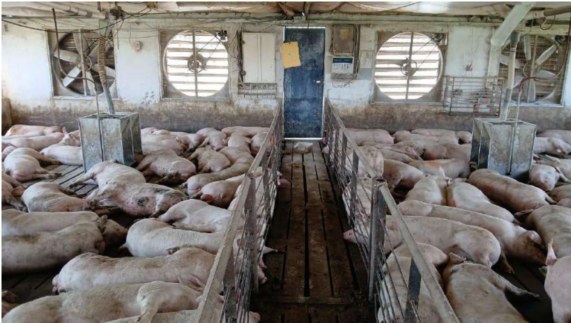
Anexo 24. Extractores de aire
