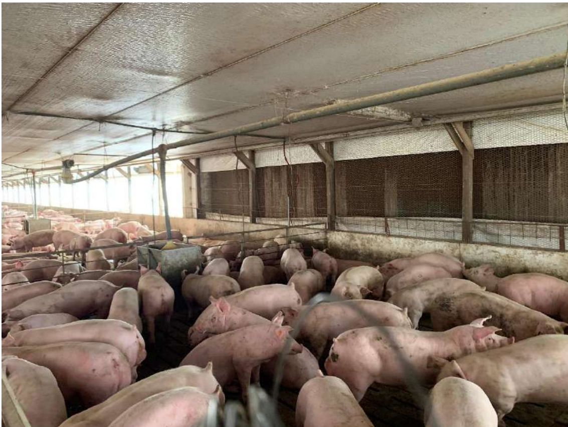
Anexo 25. Paneles de enfriamiento (Cooling pads)
