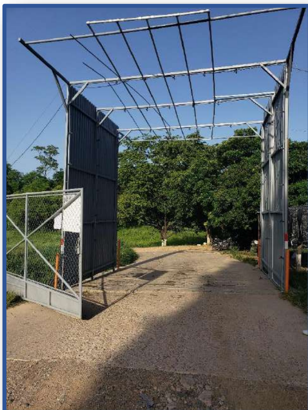
Anexo 6. Arco sanitario utilizado para el ingreso de vehículos
