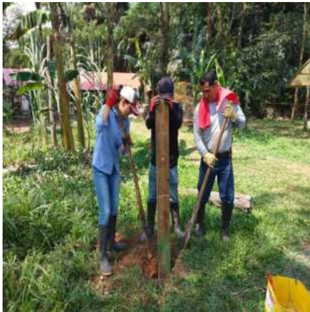
Anexo 10: Instalación de postes
