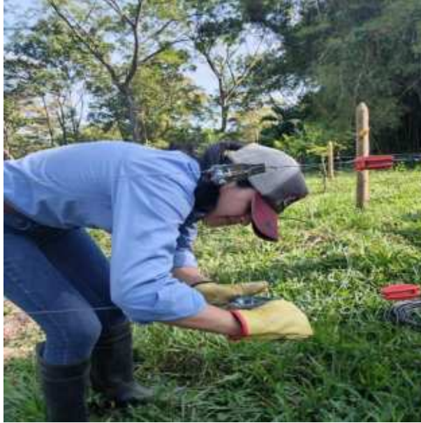
Anexo 11: Instalacion de tensores, aisladores y alambre
