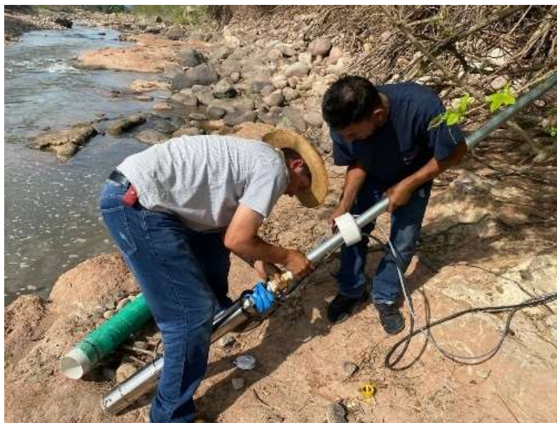
Ilustración 13. Instalación de bomba para bombeo fotovoltaico en FAS.
