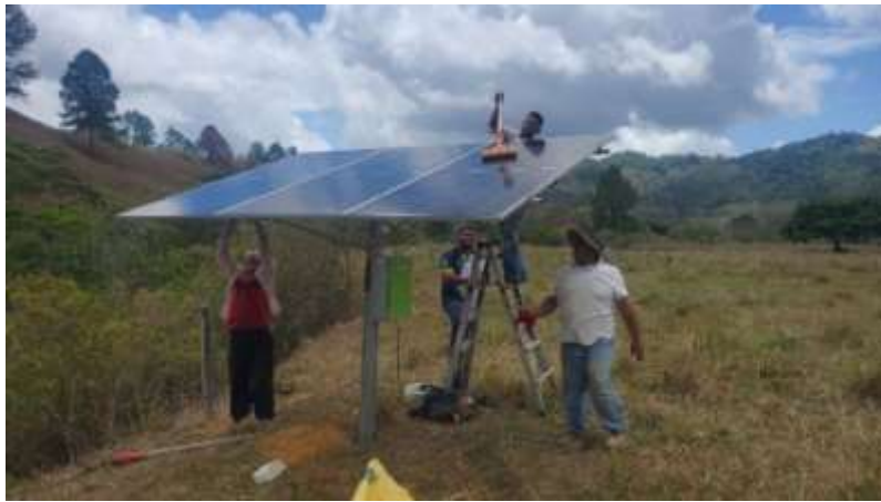
Ilustración 12. Instalación de sistema de paneles para bombeo fotovoltaico en Los Plancitos Teupasenti.
