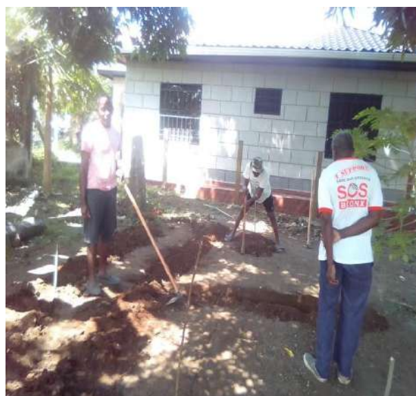
Anexo 6 Visita de campo en Corozal, La Ceiba, Atlántida.
