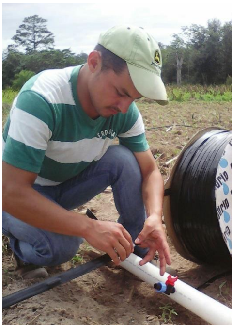
Anexo 7. Instalación de riego por sistema Goteo en parcelas.
