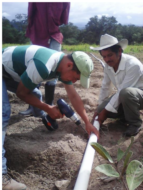
Anexo 8. Mantenimiento del De riego por goteo.
