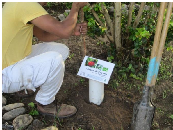
Detalle de la instalación de la base del rótulo
