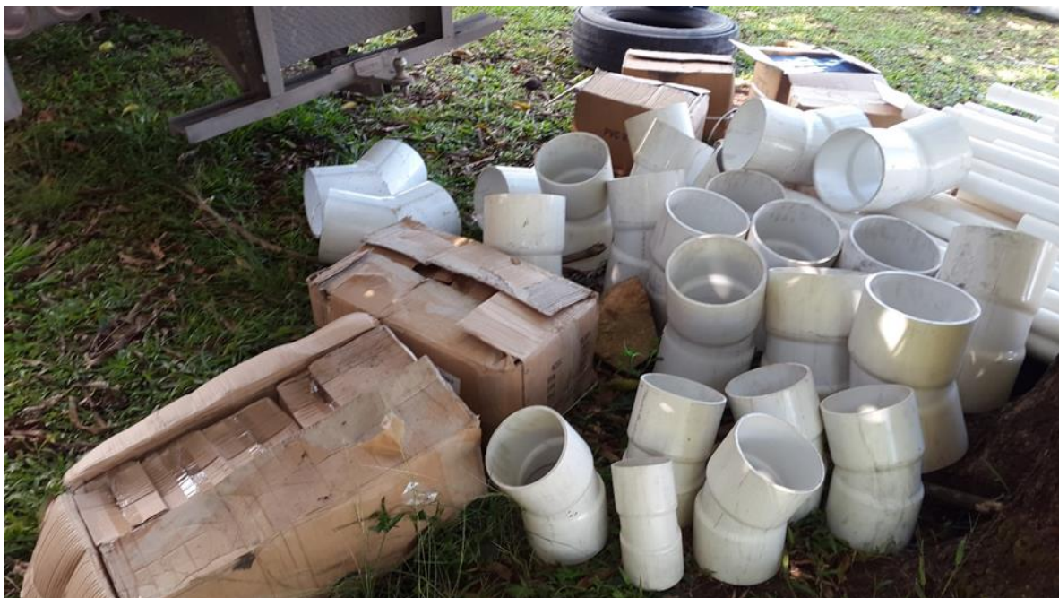
Figura 10. Recibimiento de accesorios de tubería del proyecto de sistema de riego.
