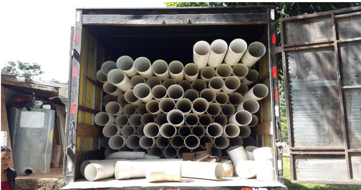
Figura 11. Recibimiento de tubería para línea de conducción.
