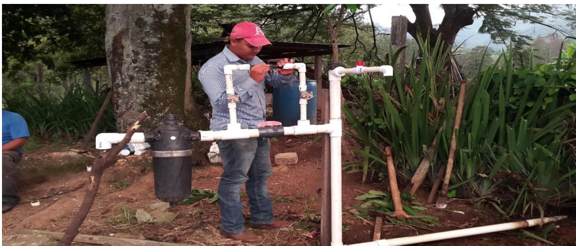
Figura 8. Instalación de sistema de riego parcelario.
