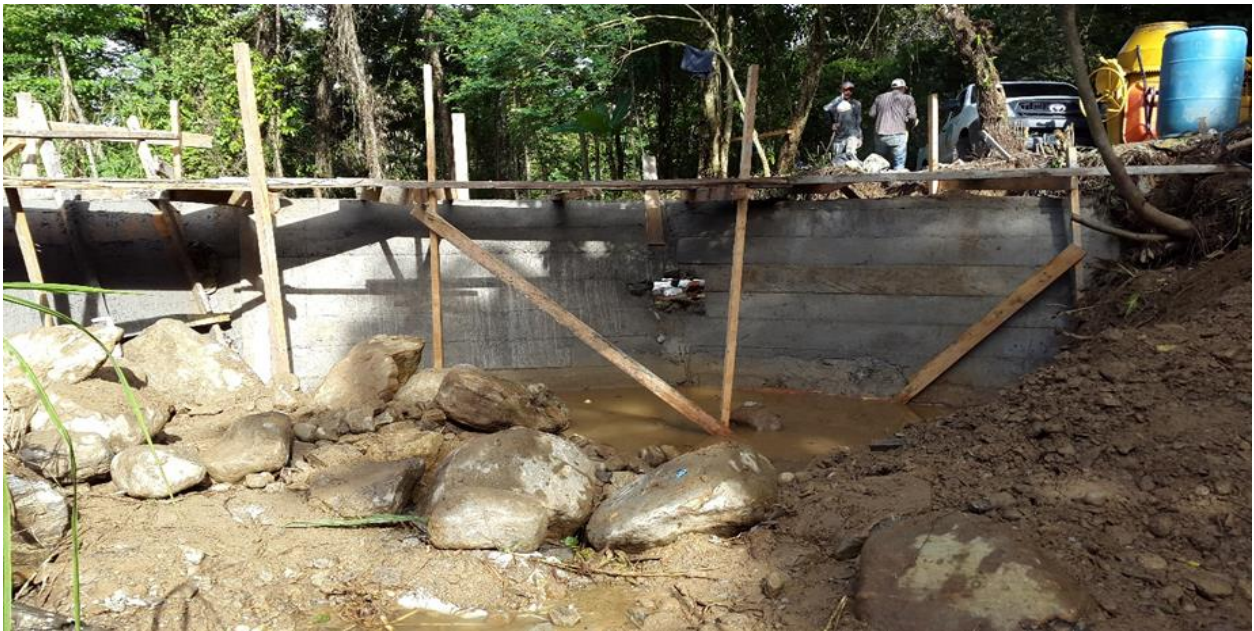
Figura 14. Supervisión de la construcción de la represa para el abastecimiento de agua para el sistema de riego.
