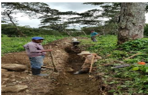
Figura 6. Trabajo de excavación de línea de conducción.
