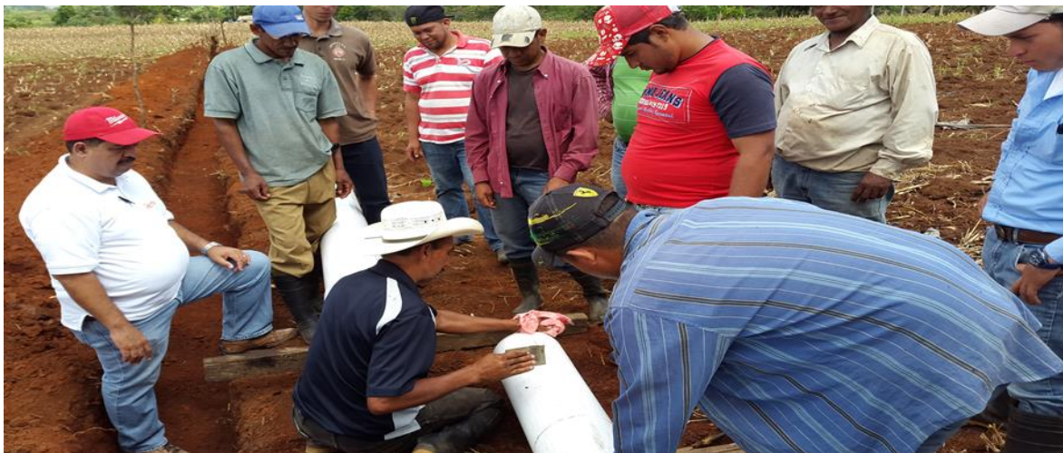
Figura 5. Practica sobre pegado de tubería.
