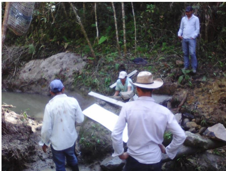
Anexo 7 Construcción de obratoma en Potrerillos La Iguala Diciembre 2015 Daneri Pineda
