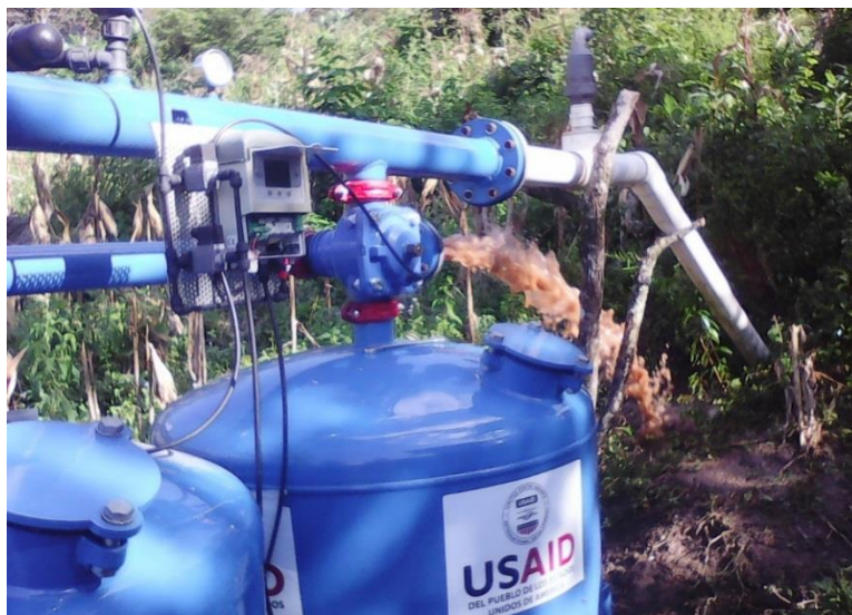
Anexo 12 Aseo de filtro en San José San Rafael.
