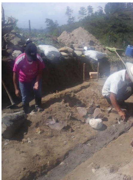
Anexo 5 Construcción del desarenador en Potrerillos La Iguala 28 octubre 2015.
