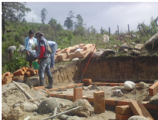
Anexo 6 Construcción de desarenador en Potrerillos La Iguala 28 octubre 2015.
