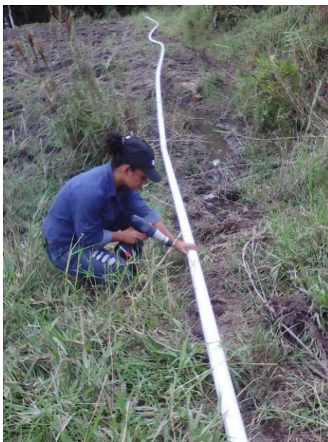
Anexo 8 Instalación parcelaria en Santo Domingo 9 de Noviembre del 2015
