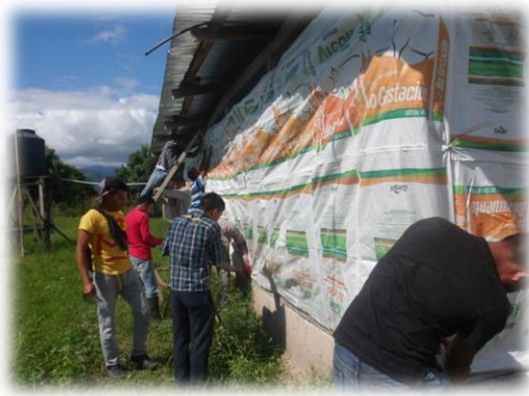
Figura 2. Instalación de cortinas
