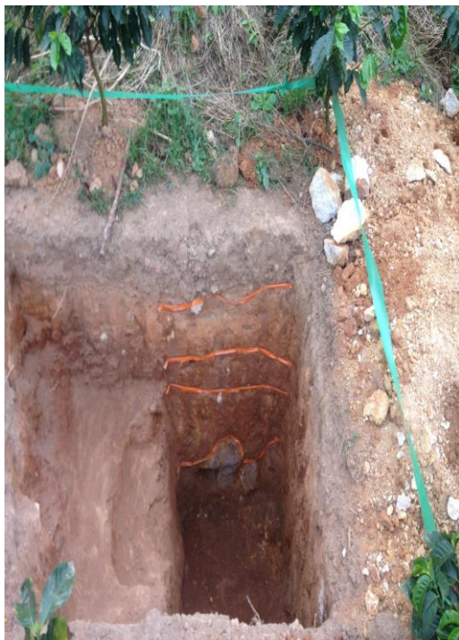
Anexo 12. Apertura de calicata en finca de 2 años.
