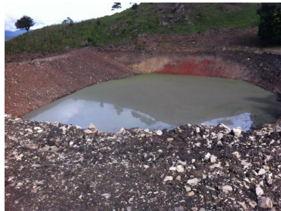
fig.2. Reservorio de agua
