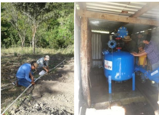
Practica V. Instalación de sistema de riego y mantenimiento de filtros de arena
