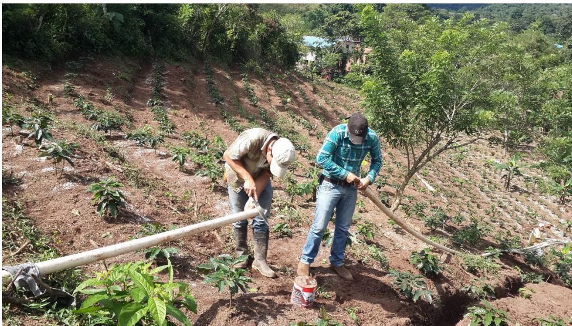
Figura 6 Instalación de la tubería de conducción primaria en la parcela.
