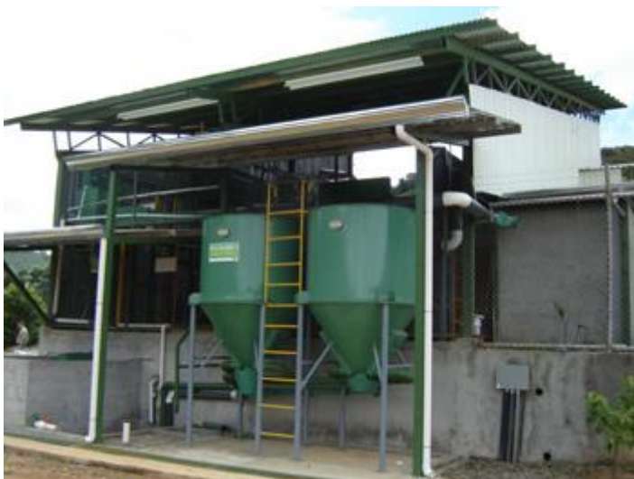
Anexo 1. Silo escurridor
